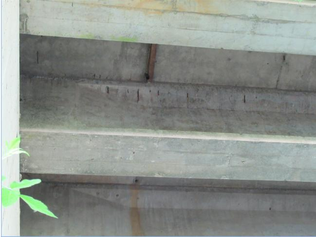
Fotografía 1: Armadura con escasez de recubrimiento
