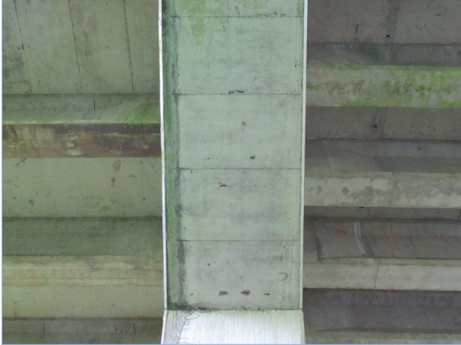
Fotografía 1: Malla de armadura a la vista y oxidada
