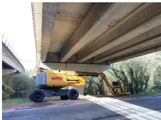
**Figura 10.** Cesta telescópica recomendada para los trabajos previos en estribos E-1 y E-3.
