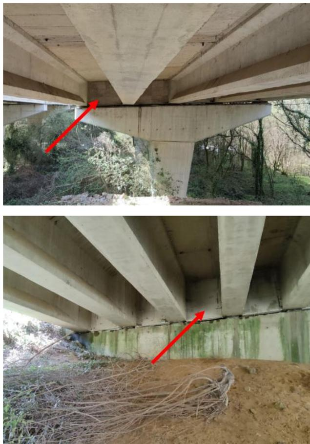
**Figura 6.** Traviesas cosiendo las vigas del tablero en apoyo sobre pila (imagen superior) y sobre estribo (imagen inferior)
