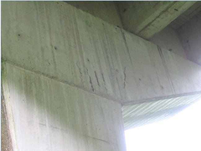
Fotografía 3: Malla de armadura a la vista y oxidada
