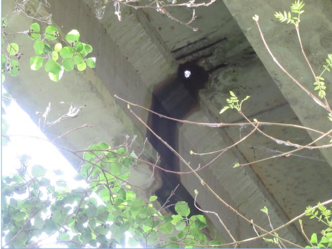
Fotografía 1: Desprendimientos del recubrimiento
