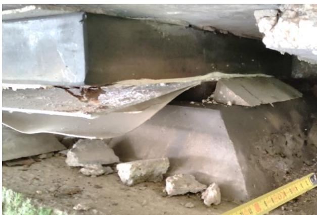
**Figura 17.** Mesetas de apoyo a demoler.
